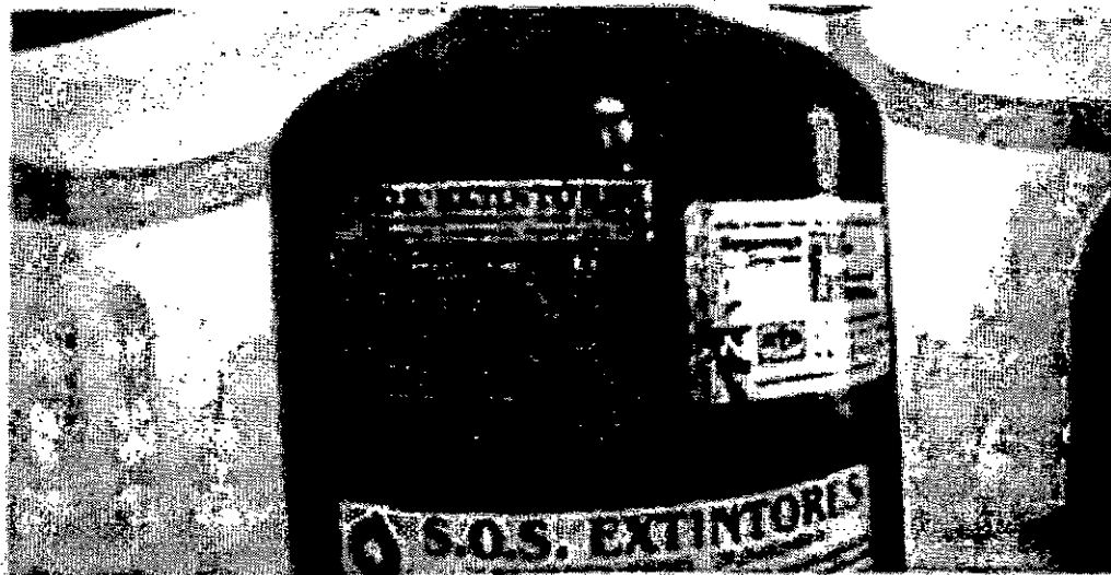
Figura 6 - Extintor localizado no canteiro de obras
